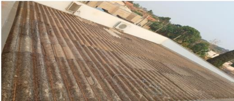
Local onde será instalado os painéis.
